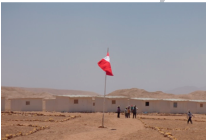
Módulos de vivienda instalados en Nuevo Querapi (Pampas de Jaguay), para los desplazados de Querapi. Se instalaron cerca de 70 módulos.
